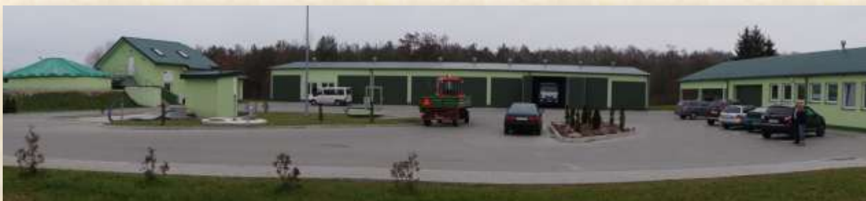
Inwestycja wykonana przez P.R.B. „REMBUD” – Oczyszczalnia ścieków w Skrobowie
